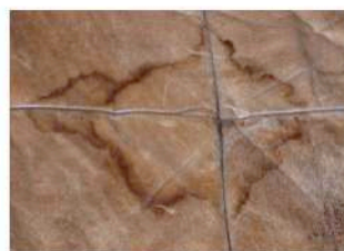
Manchas de agua en piel anilina
