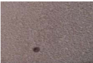
Las quemaduras de cigarrillo no se pueden reparar.
